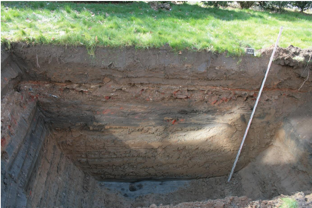
Abbildung 13 Abtiefung bis unter 3,5 m unter GOK in AB 5
