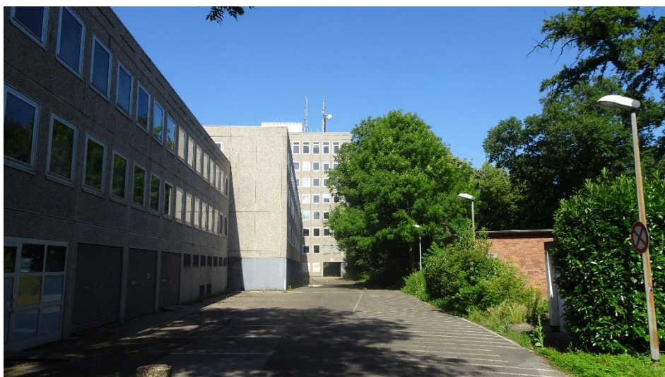
Abbildung 8: Blick auf die nördlichen Fassaden des Finanzamtes (ISR 2021)
