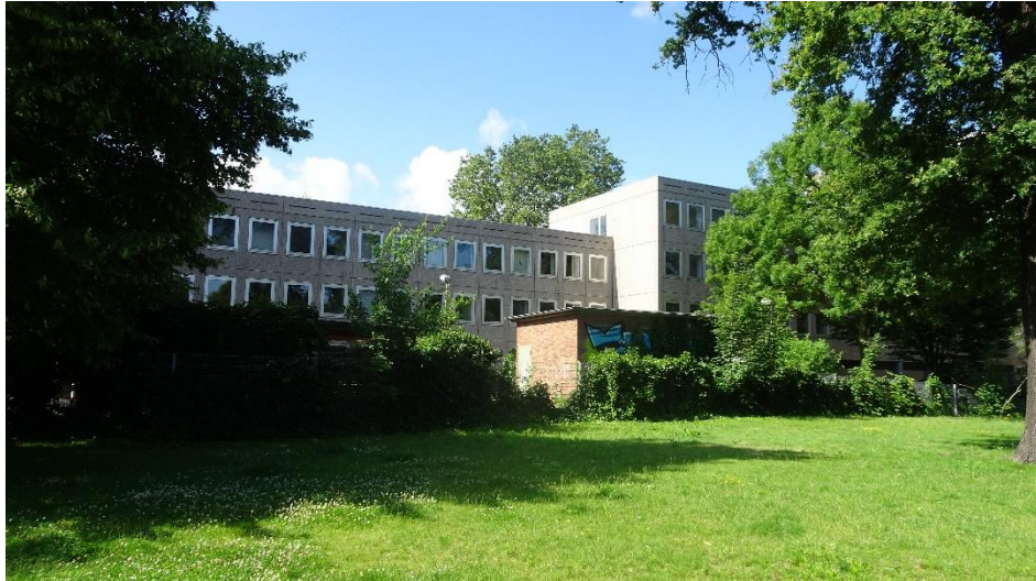
Abbildung 9: nördliche Fassade des Finanzamtes/Gehölzstrukturen in Norden (ISR 2021)
