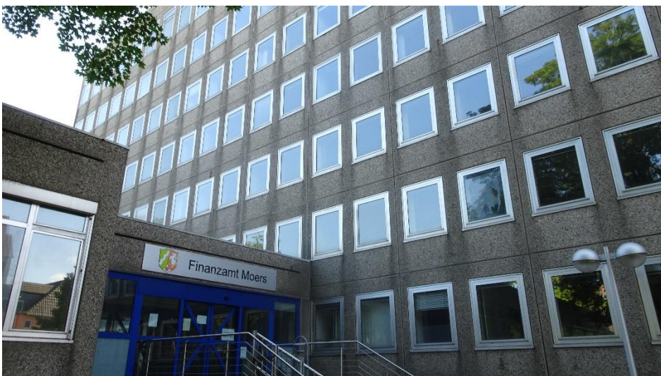
Abbildung 5: intakte Fassade/Fenster (ISR 2021)
